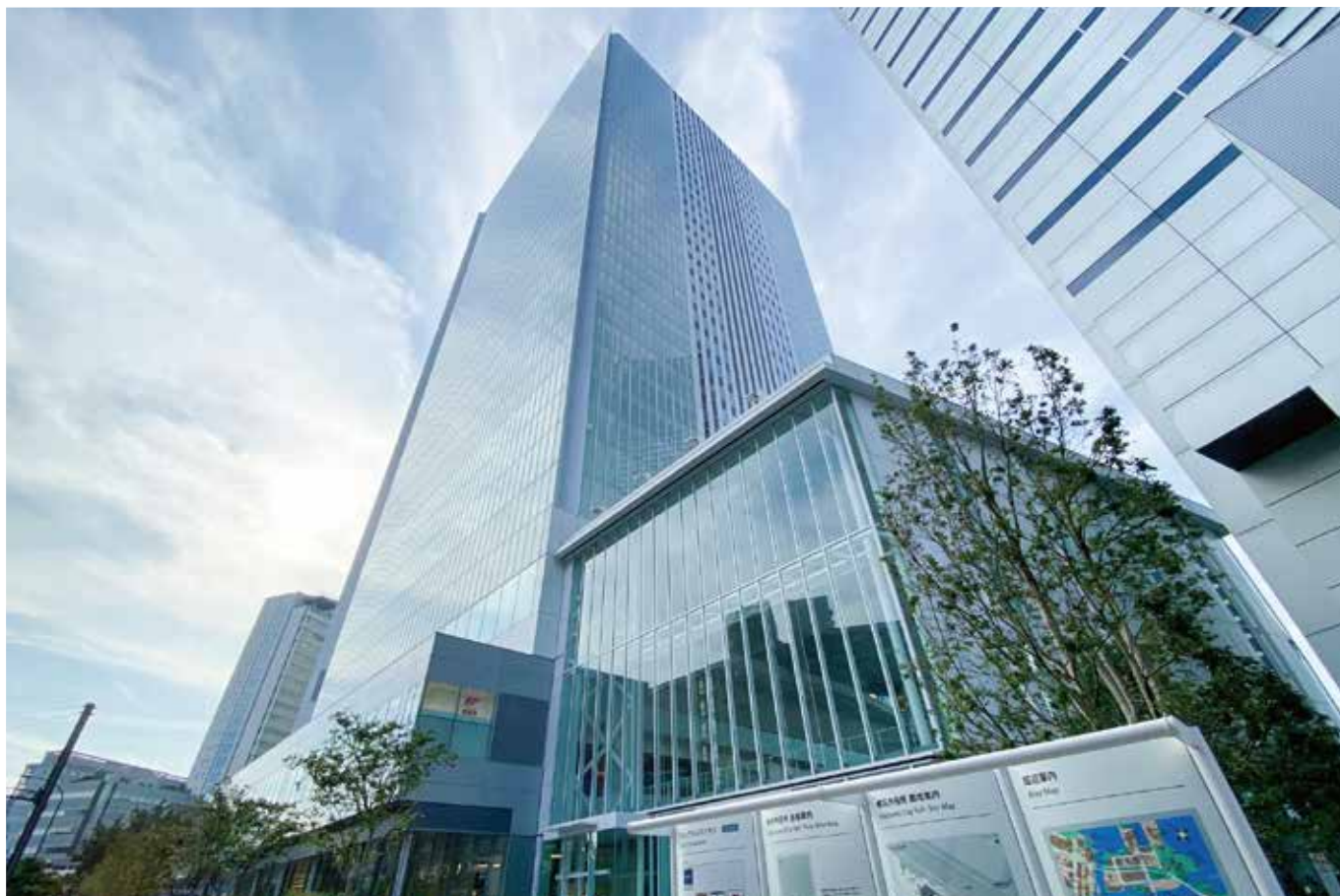
横浜市新市庁舎
